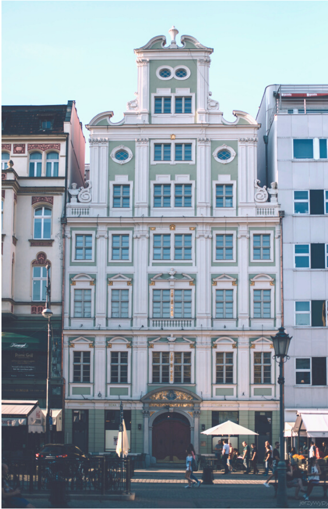
Front kamienicy, w której znajduje się OP ENHEIM
