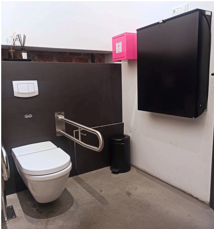
Łazienka na poziomie -1
