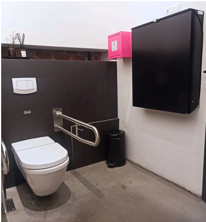
Łazienka na poziomie -1
