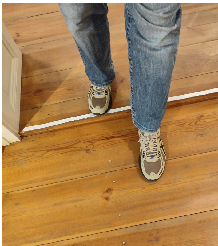
Niewielki próg przy przejściu do 2 sali.
